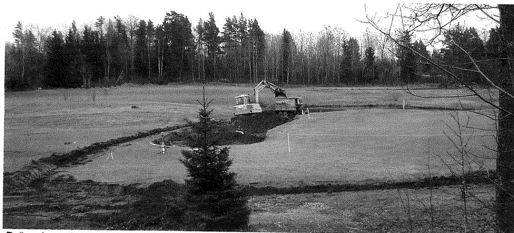
Dränering o bunkerförbättring på hål 16
